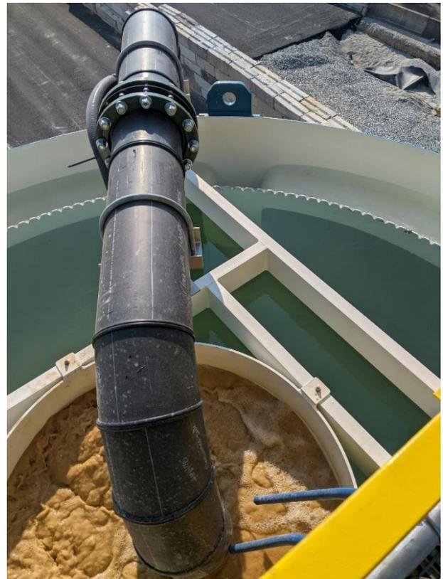
Le trop-plein d'eau clarifiée provenant du clarificateur s'écoule vers un réservoir d'étage de 3000 gallons avant de retourner dans le processus de production.
