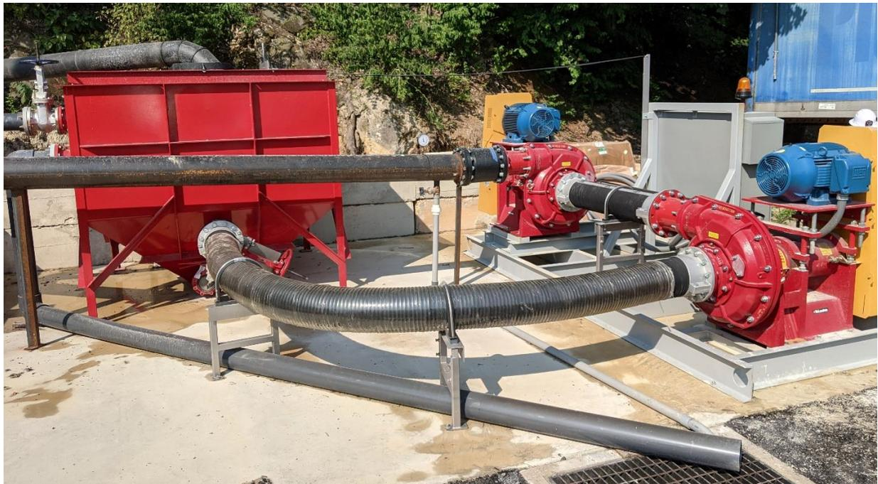
Afin d'utiliser l'eau clarifiée comme eau de dilution pour le système de dilution des polymères secs M800SS, Clearwater a installé deux filtres à poches et un filtre à cartouche de 30 microns. Les filtres garantissent une eau de dilution propre pour préparer une solution de polymère efficace et uniforme.
